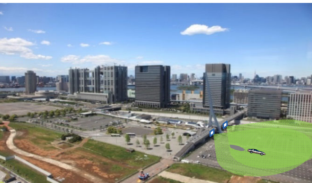
広い敷地内でのカバレッジ試験及び屋外走行試験
